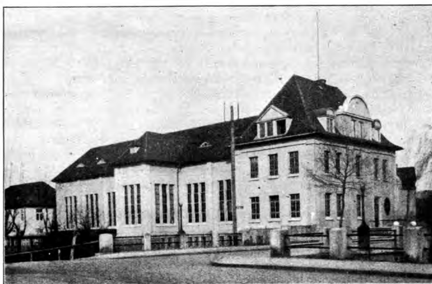
Abb. 3. Ansicht von Westen.
